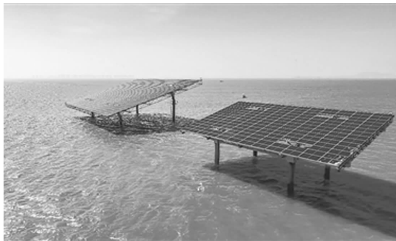
位于山东省海阳市近海的桩基固定式海上光伏项目。
