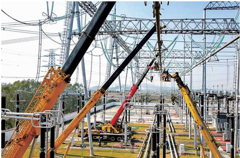
2022年12月27日，阳江供电局在500千伏回隆变电站更换500千伏1M管型母线。
