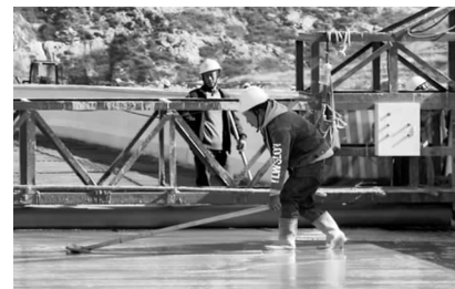
国道338孟县公路改线工程施工现场
