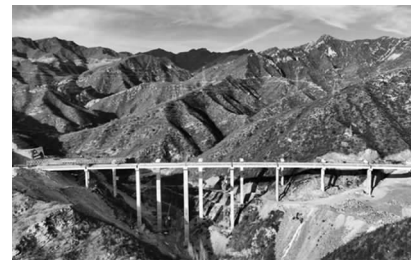
国道338孟县公路改线工程施工现场
