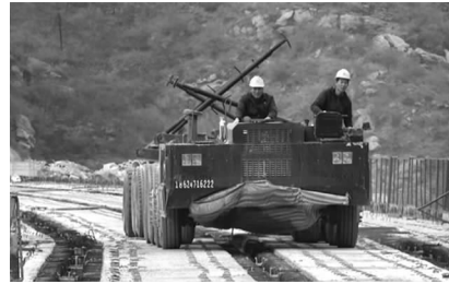
国道338孟县公路改线工程施工现场
