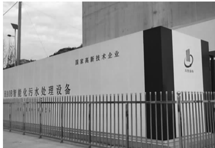
智能化污水处理设备。
