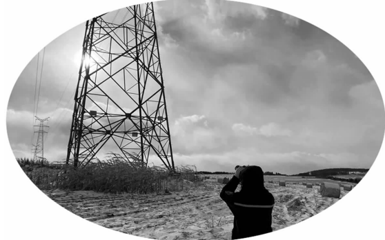
3月19日,吉林延边供电公司员工张航巡检220千伏图延甲乙线25号塔。 胡泽浩摄
