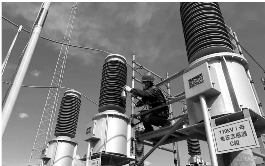
3月19日,新疆博尔塔拉供电公司员工曹双波在220千伏博乐变电站为110千伏I母电压互感器喷防污闪涂料。 闫林冲摄
