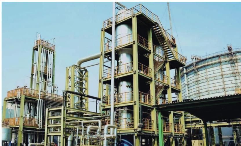
首钢京唐公司 300 吨全流程工业煤气制清洁能源燃料乙醇示范装置。资料图片
