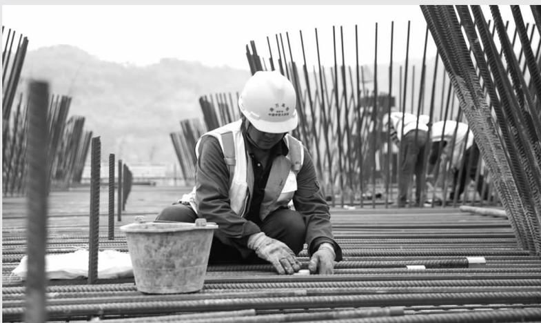
3月29日,由中铁大桥局承建的渝万高铁关键节点工程石沱长江大桥南北两岸主塔桩基施工全部完成,工程将全面转入承台施工阶段。
