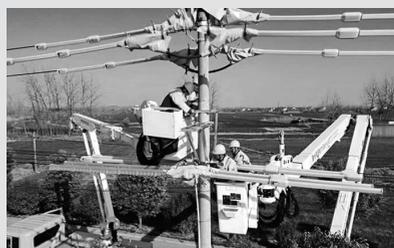
3月26日,安徽滁州天长供电公司员工在10千伏新华线225号杆安装配网保护开关。 周阳摄
