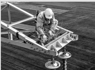
3月26日,安徽淮南供电公司员工在潘集区平圩镇为500千伏洛平线40号塔安装防护装置。 王明松摄
