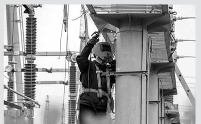
3月24日,河南郑州供电公司员工在220千伏柳林变电站更换电流互感器。 罗浩摄
