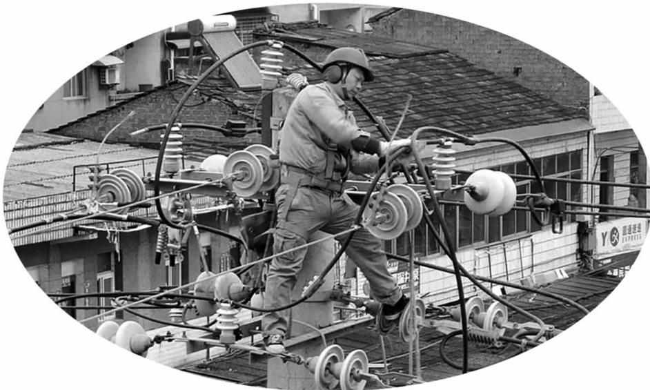
3月24日,湖北襄阳供电公司员工在10千伏结542线290号杆更换绝缘导线。李兴全摄
