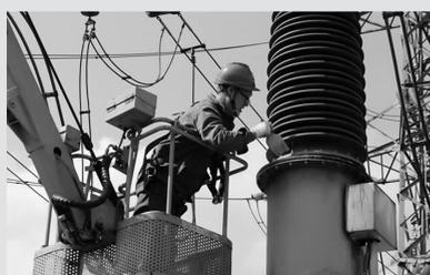
3月21日,四川广安供电公司员工陈林在220千伏铜堡变电站为电流互感器刷防腐漆。 余炎摄
