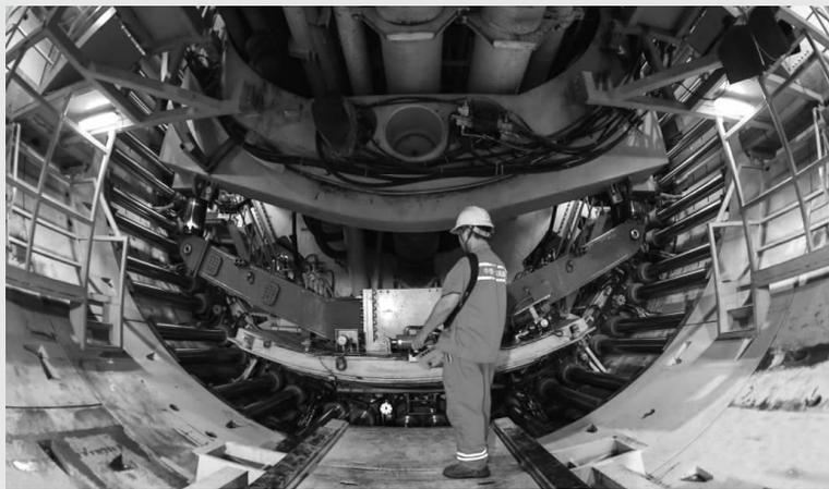
深(深圳)江(江门)铁路横穿珠江的珠江口隧道由两台直径超13米的巨型盾构机从东莞虎门和广州南沙两端分别盾构掘进,目前隧道盾构段已掘进过半,珠江口隧道全长13.69公里,海底最大埋深达115米。
