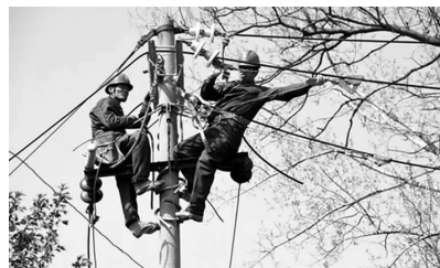
3月30日,陕西西安临潼供电公司员工在何寨街道董村10千伏线路132号杆上更换绝缘导线。 潘世策摄
