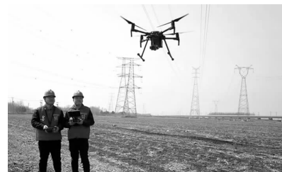
3月27日,辽宁铁岭供电公司员工使用无人机巡检500千伏安蒲线113、114号塔。 张于 王贺摄影报道
