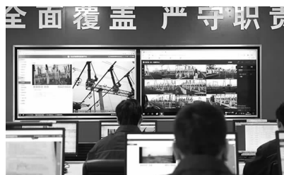
3月23日,安徽淮南供电公司安全督察人员在安全督察中心远程监控检修现场作业情况。 孟晨辰摄
