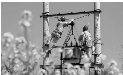
3月30日,江苏徐州邳州供电公司员工在戴圩镇增容改造10千伏圩华线戴场村9号公用变压器。 曹庆升摄
