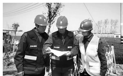
3月28日,河南鹤壁浚县供电公司安全督察人员在10千伏卫北线检修工作现场检查工作票签发情况。 王世文 郭顺发摄影报道
