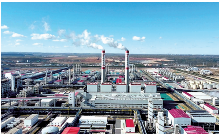
该公司1500万吨/年煤炭分质清洁高效转化示范项目一阶段鸟瞰图
