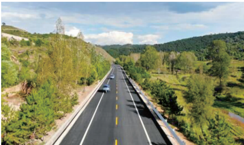
国省道路路面改造工程现场
