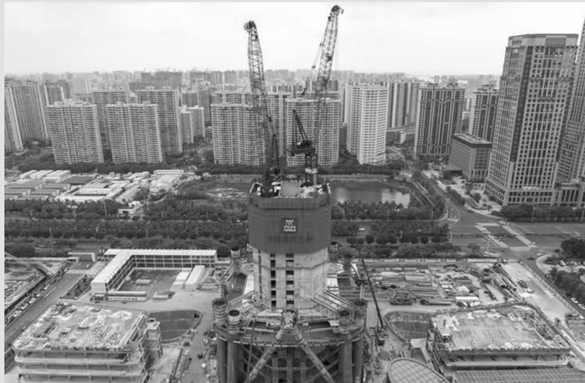
日前,由海南机场投资、中建三局承建的海南中心项目安装完成“空中造楼机”,这也是最新一代“空中造楼机”首次亮相海南。海南中心项目位于海口市国兴大道,建成后高度将达到 428 米,是集观光游览、超星级酒店、高级写字楼、精品商业等多功能于一体的超高层综合体。(无人机照片)
