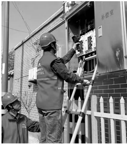
5月3日,河北保定定州供电公司员工渠占民、李立杰巡检10千伏寺羊平线小陈村2号台区配电设备。 来瑞摄
