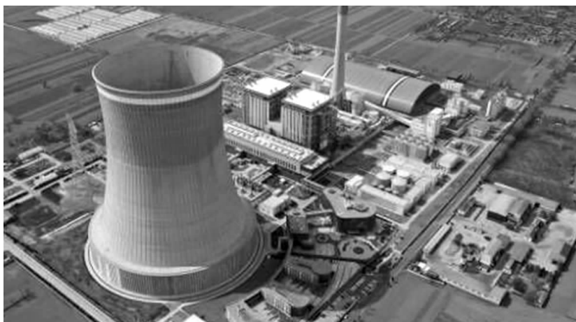
潞安高河能源低热值煤发电项目具备特高压外送、城市供热、低热值煤发电、煤电一体化四大特点,对实现低热值煤资源就近高效转化、提高煤炭资源利用效率具有重要的示范意义。 资料图片
