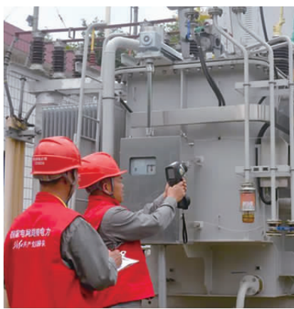
6月12日，湖南怀化靖州供电公司党员服务队队员陈明科、蒙永保在35千伏藕团变电站巡检1号主变压器。 石云昌 摄
