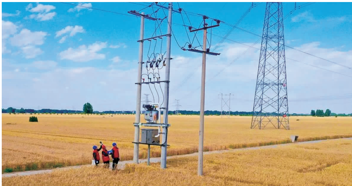
6月9日，河北保定定州供电公司员工白磊、席跃宗等巡检10千伏王家庄线8号杆上设备。 来瑞 摄
