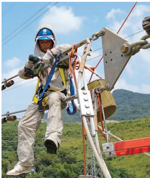
6月12日，福建福州供电公司员工吴能锦在晋安区新店镇益凤村220千伏榕黎Ⅱ线27号塔上带电处理耐张线夹发热缺陷。 陈德钧 摄
