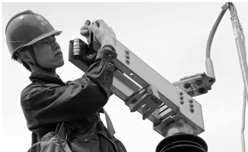
5月12日，新疆伊犁伊河供电公司员工台翔龙在110千伏莎木于孜变电站为110千伏托木线间隔隔离开关触头除锈。 赵卯呈摄
