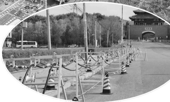
▲鞍山供电公司带电作业员工将10千伏千山线134号杆由直线杆改为耐张杆。
