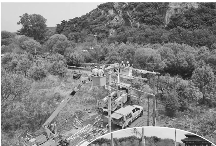
▲鞍山供电公司带电作业员工将10千伏千山线134号杆由直线杆改为耐张杆。
