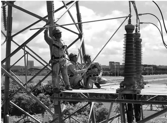
7月4日，福建福州供电公司员工郑永健、吴克宇、卓晗在平潭岛湖中路110千伏竹厝线1号塔上采用地电位带电作业法为电缆终端头加装导流夹具。
