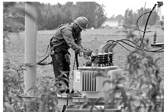
7月17日，河南鹤壁淇县供电公司员工岳纲水紧固10千伏马庄线抗1号台区低压侧设备线夹。
