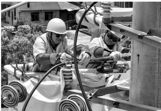
7月16日，湖南怀化洪江供电公司员工黄记华、杨利在10千伏电石厂线工业园支线01号杆开展引线解头作业。
