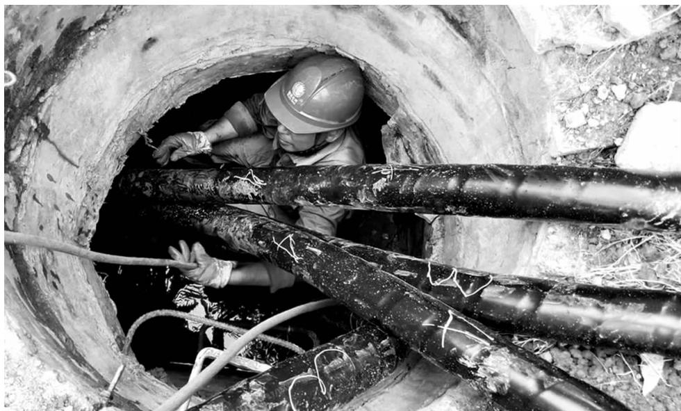
7月13日，湖北襄阳供电公司员工朱德方在襄阳汉江生态城小区新建的10千伏开闭所8号电缆井内敷设电缆。
