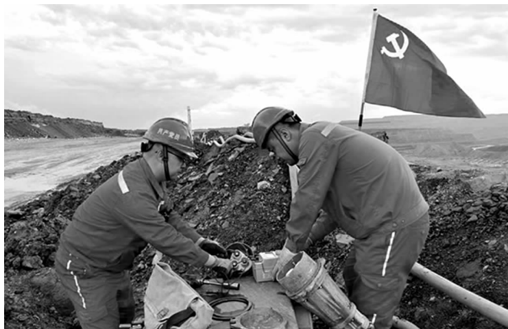
党员和职工正在排查供电线路隐患
