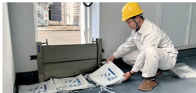
9月1日，上海青浦供电公司员工瞿殿桂在35千伏赵巷变电站开展防台风防汛加固工作。 戴焯敏 摄
