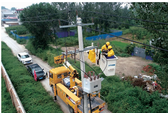
9月4日，河北保定高碑店供电公司员工李闯、吴立涛更换10千伏龙堂线龙兆庄分支线01号杆设备线夹。 郝嘉璐 摄
