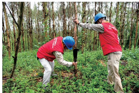
9月1日，福建漳州云霄供电公司员工陈秋敏、陈永武在10千伏陈港I、II线91号杆附近清理树障。 方志杰 摄
