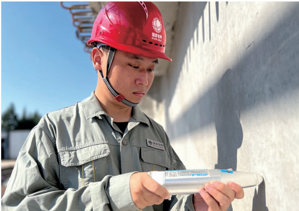
9月4日，湖南送变电公司员工李浩洋在500千伏张家界变电站新建工程现场测量进站桥梁预制T梁混凝土强度。 毛锦伟 摄
