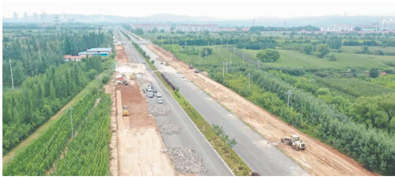
襄垣县道王南线北底至西五线段(高铁站前路)道路工程
