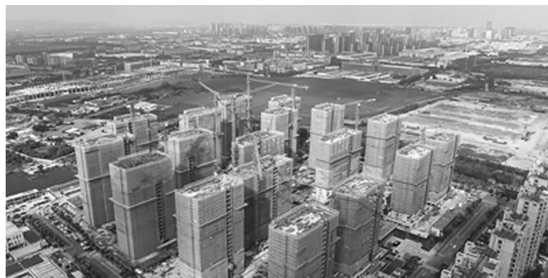
图为近日顺利结顶的浙江省宁波市江北应家保障房地一地块项目。
