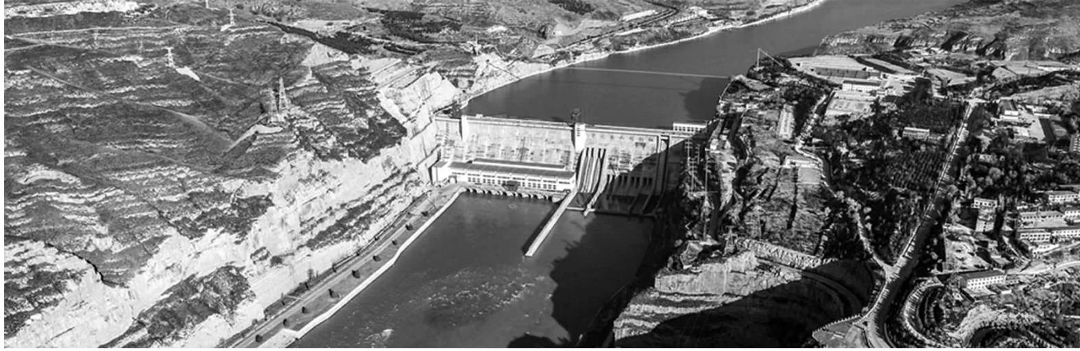
位于偏关县黄河干流上的万家寨水利枢纽是万家寨引黄入晋工程的起点。 高晓忠 / 摄
