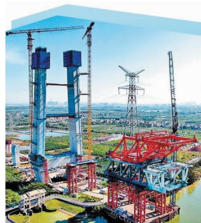
深江高铁洪奇沥水道公铁大桥首节段钢架架现场。 邓华/摄
