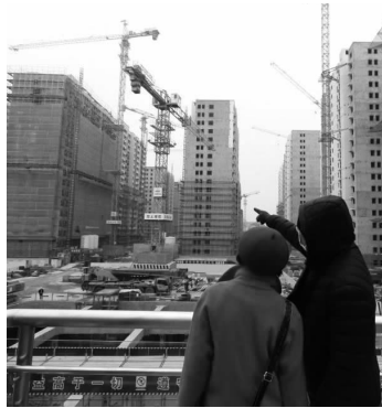
1月10日,两位市民在上海彭浦新村地铁站出站天桥上观看彭一小非成套旧住房改造工程建设工地。 方喆 摄
