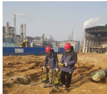
图为山东省煤田地质局物测队的技术人员在施工中。
