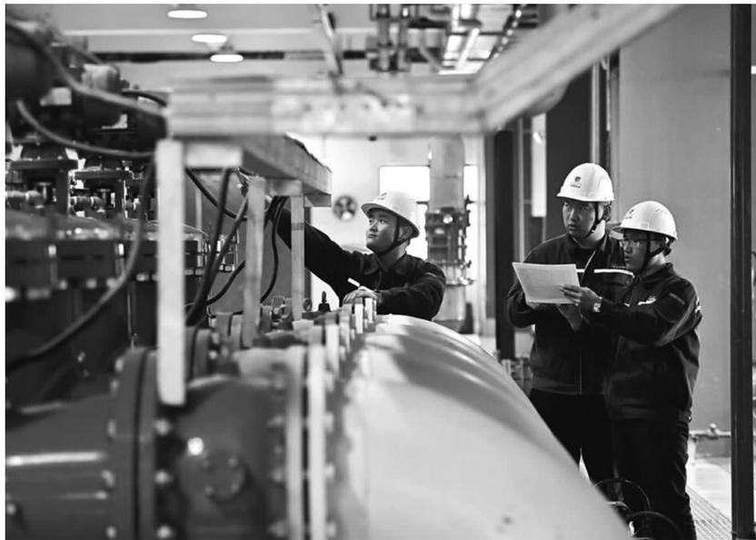
3月19日，太原市再生水综合利用示范基地内，工作人员正在查验供水设备。该基地占地面积约1.25万平方米，通过“超滤+反渗透”双膜工艺，去除水中绝大部分杂质和离子，为山西省大型工业企业高品质用水提供稳定供应。 王瑞瑞 摄
