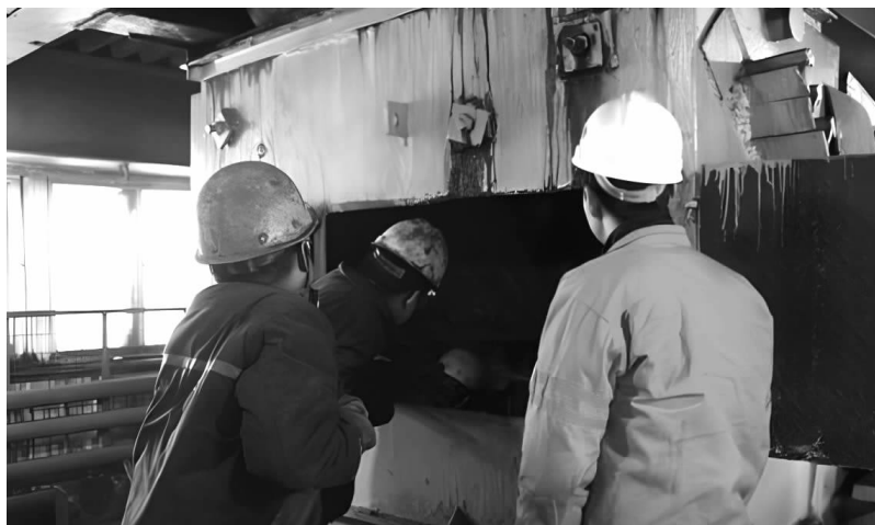
图为施工人员进行系统检修。
