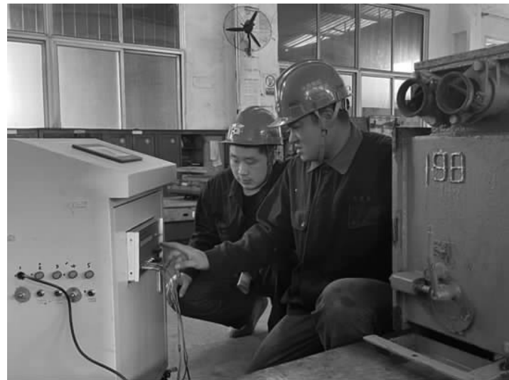
工作人员使用电气综合维修试验装置对隔爆开关进行检查。
