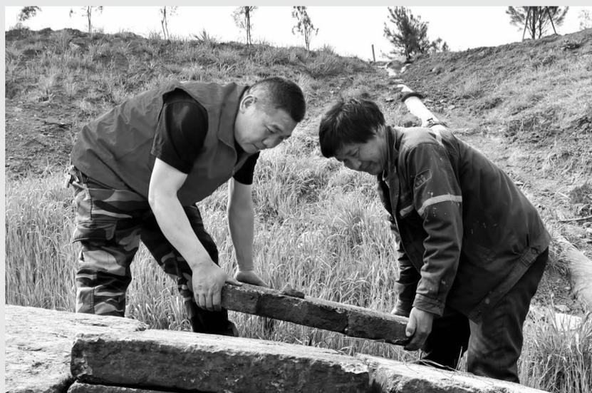
进入雨季以来，为了防御汛期水害，提高抗灾能力，河南能源义煤公司新安煤矿切实把雨季“三防”工作摆到重要位置，严格落实防汛应急预案，每周定期对矿区各地点排水渠、防洪沙袋、备灾物资、各供电系统主要设备及避雷设施等进行全面检查测试，确保矿区生产和生活的安全运行。图为5月16日，该矿运输队职工正在利用废弃水泥板构筑排水渠。
