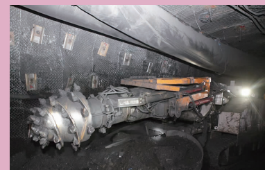
寺河矿井下连掘机掘进工作面
