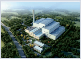
山西诚泰建筑工程有限公司 案例——阳曲发电厂项目
