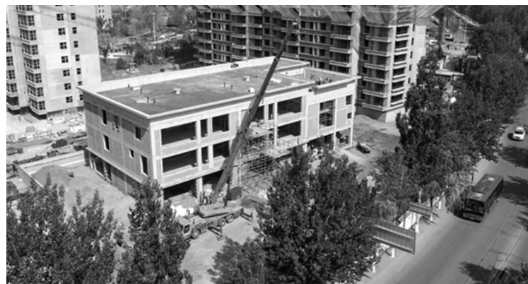
襄垣县公办示范性综合托育机构项目施工现场
