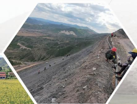
▲2#排土场无覆土台阶坡面植被恢复施工
