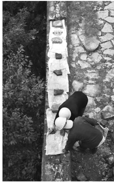
在箭扣长城 122 号敌台东侧墙体，工人给刚刚砌好的砖盖上编织袋遮雨。 陈钟昊 摄
