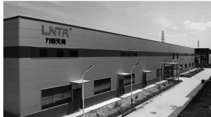
山西力诺天润动物药业生产厂房。
