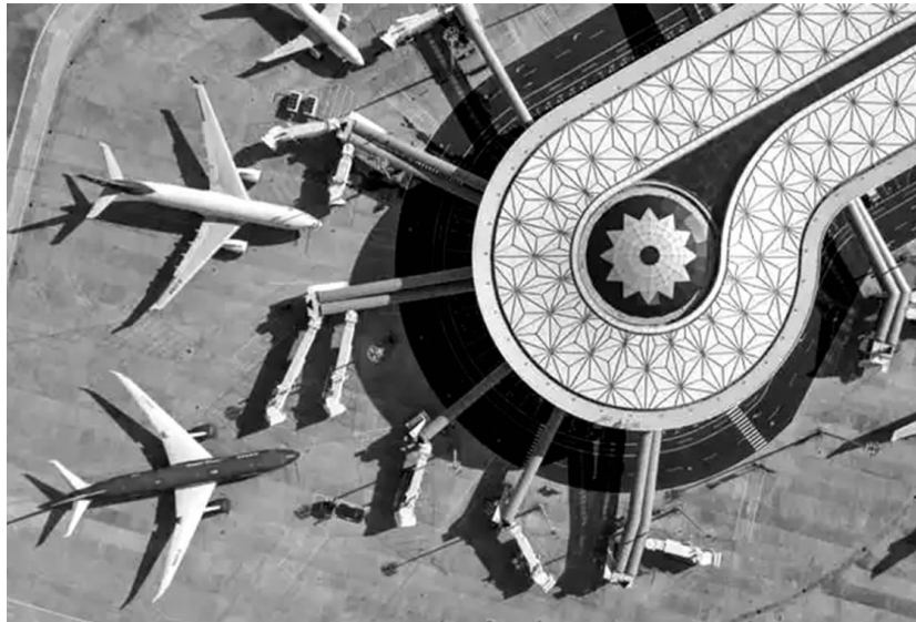
太原机场三期改扩建工程。 资料图片
