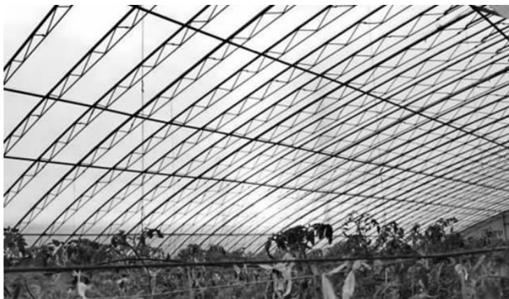
分光生态聚能膜呈淡红色,棚内为散射光。
