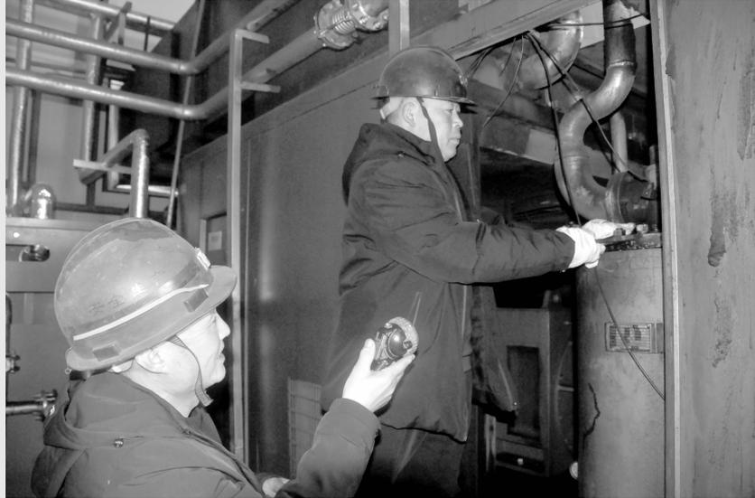
2月18日，太原煤气化华泓煤业公司对2号机组仪用空压机电机进行换型更换。机电队空压机项目工作人员针对现场风险点制定了安全措施，对作业人员进行详细安全技术交底，专职安全员全程监护，确保工作安全有序进行。更换过程中，检修人员工作前用10KV验电棒对空压机进线电源验电，确认无电压后拆除三相电缆，对电机本体进行直阻和绝缘测量，确认电机绝缘为零后更换新电机，检修人员配合默契，最终仅用2个小时圆满完成任务，为公司安全生产提供了有力保障。赵亚利/摄
