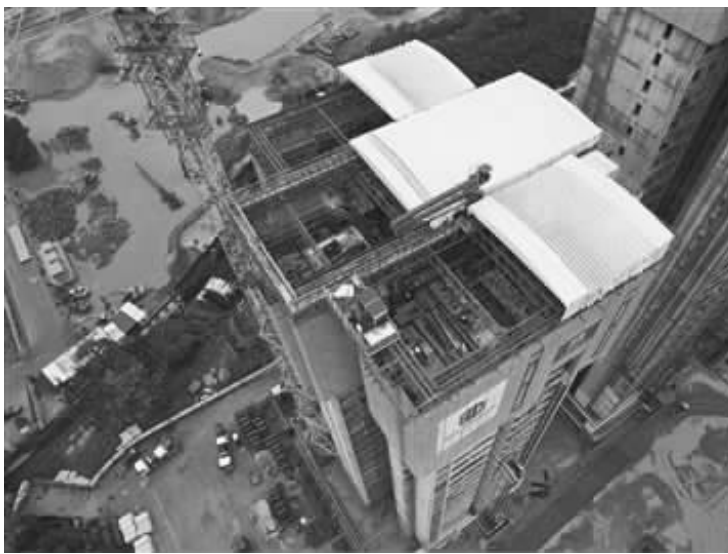
住宅造楼机作业中。
